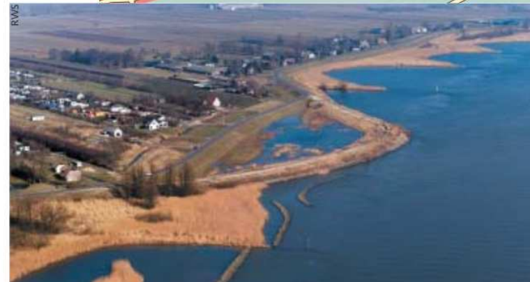
De westelijke Lekdijk, voordat deze meer landinwaarts is gelegd.
